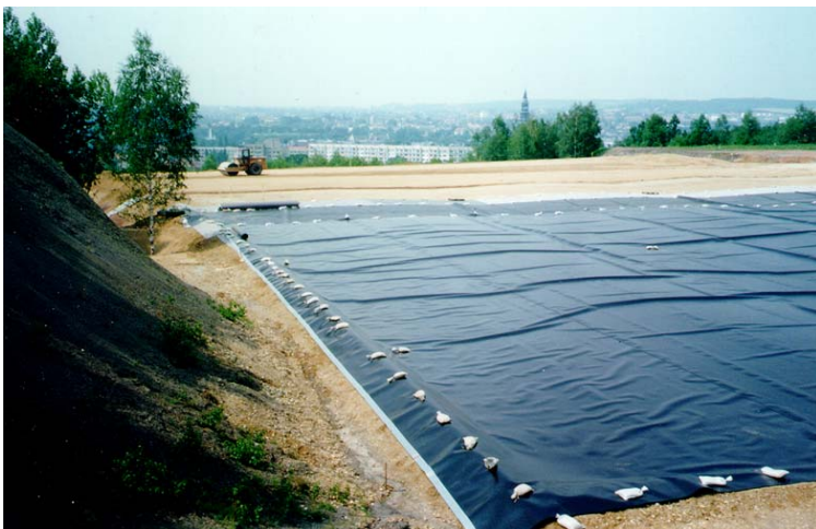
Verlegung der Kunststoffdichtungsbahn
