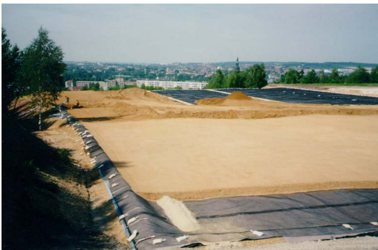
Verlegte Geokunststoffe und Aufbau der oberen Tragschicht
