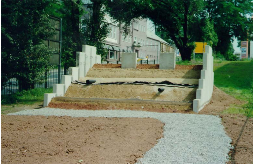
Aufbau des Drain- und Dichtsystems (Modell)
